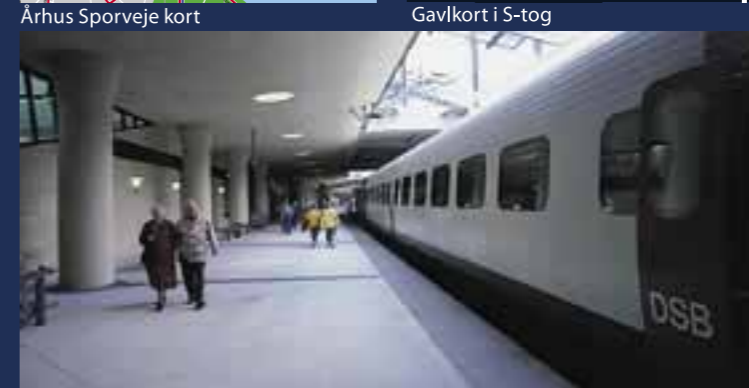
Kastrup Lufthavn station Bygningsrådgivning
